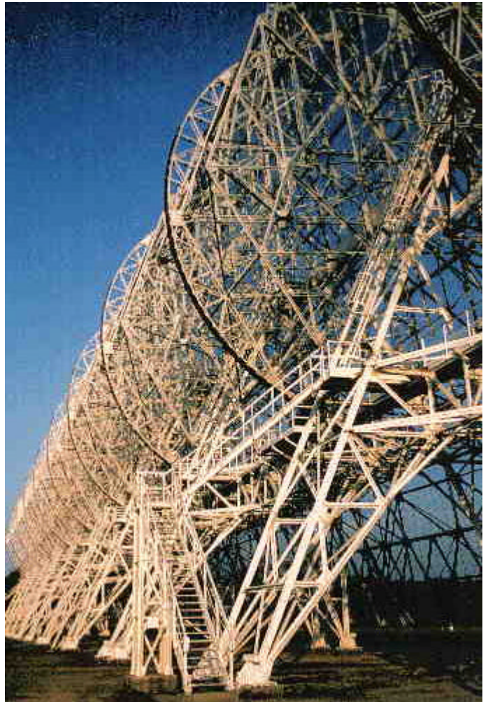
Nancay - Vue du système de positionnement du cœlostat
