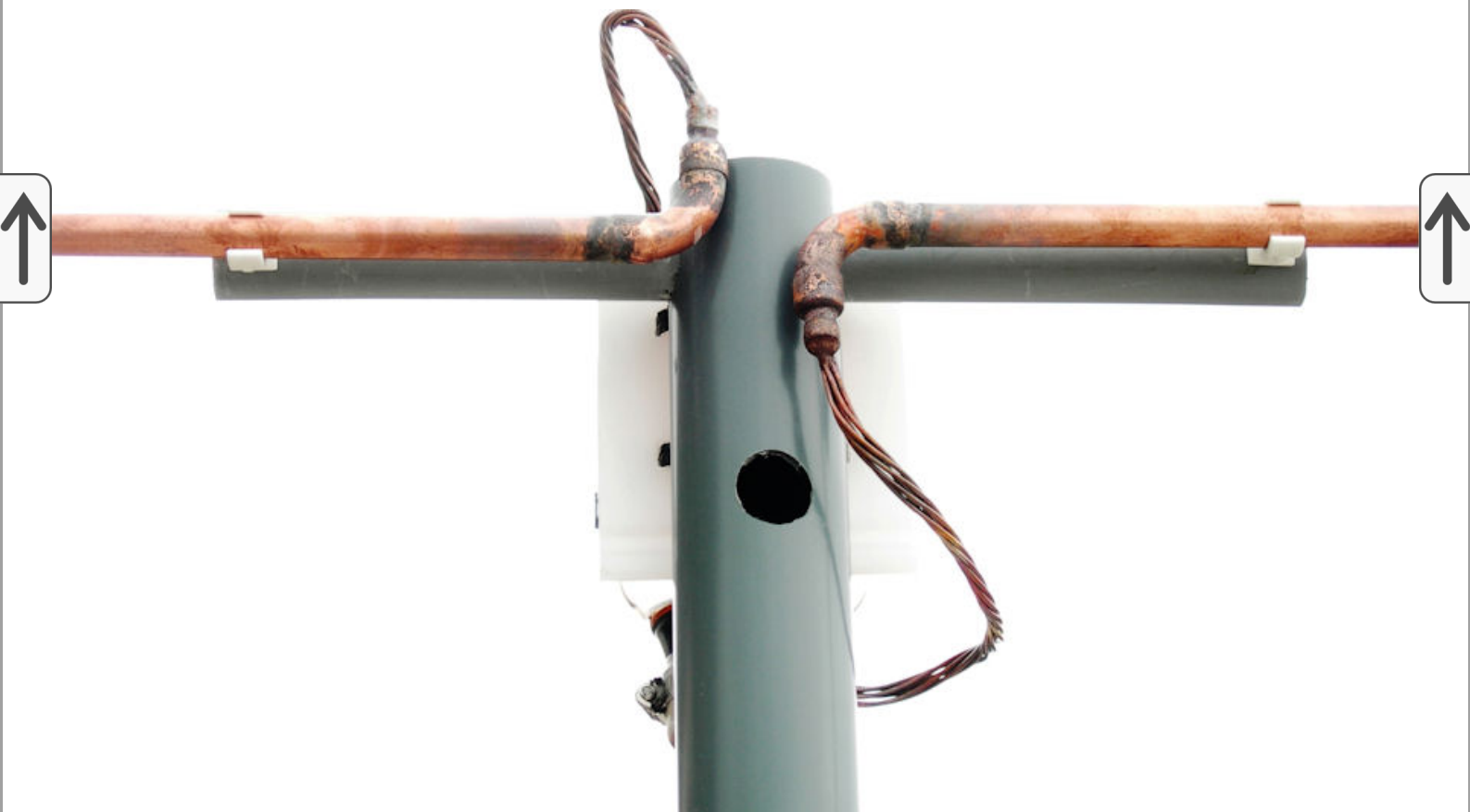
Figura 54 La parte posterior del montaje del condensador (el orificio en el mástil es para insertar una llave de tubo para apretar la tuerca en el perno inferior de la placa de montaje del condensador)
