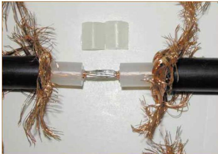
Figura 4: conductores centrales soldados.
