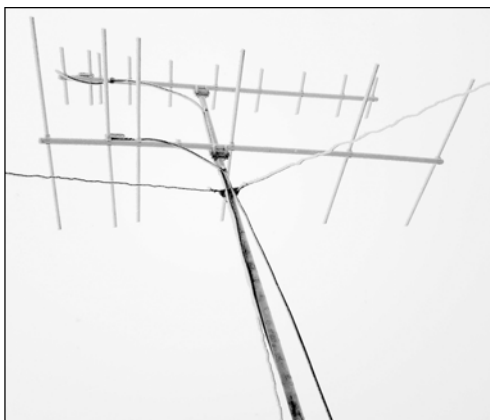
Obr. 1.: Námraza na anténách OK1JD
