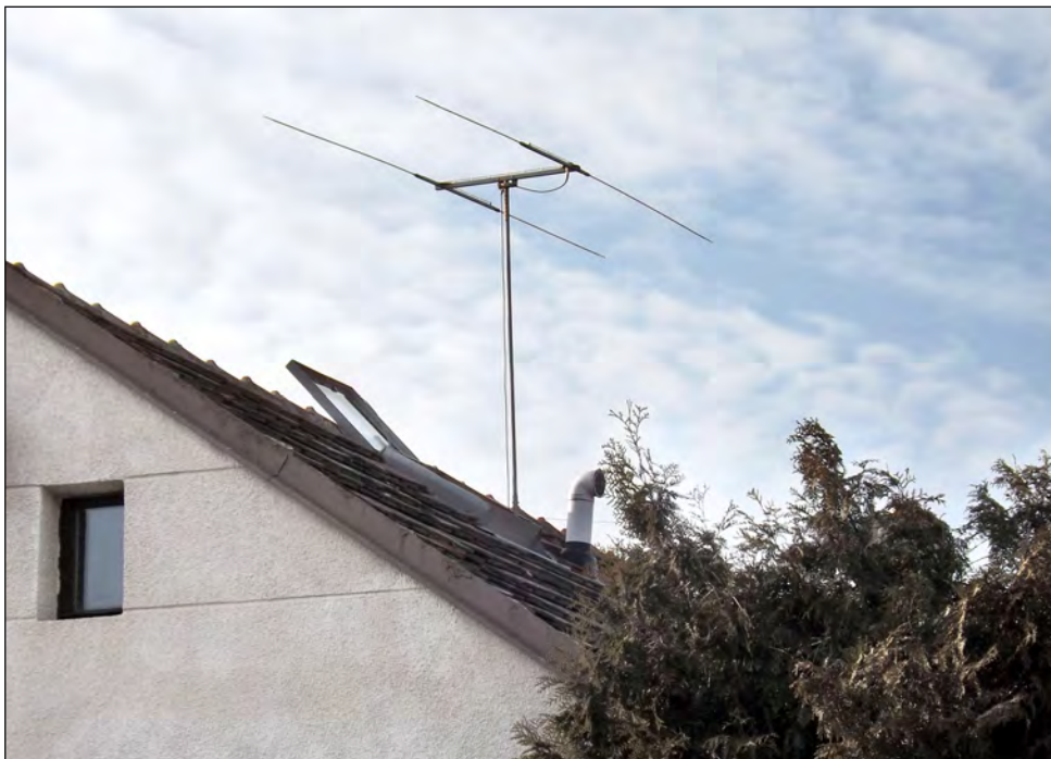
Obr. 6.: Instalace antény na střešním stožáru
