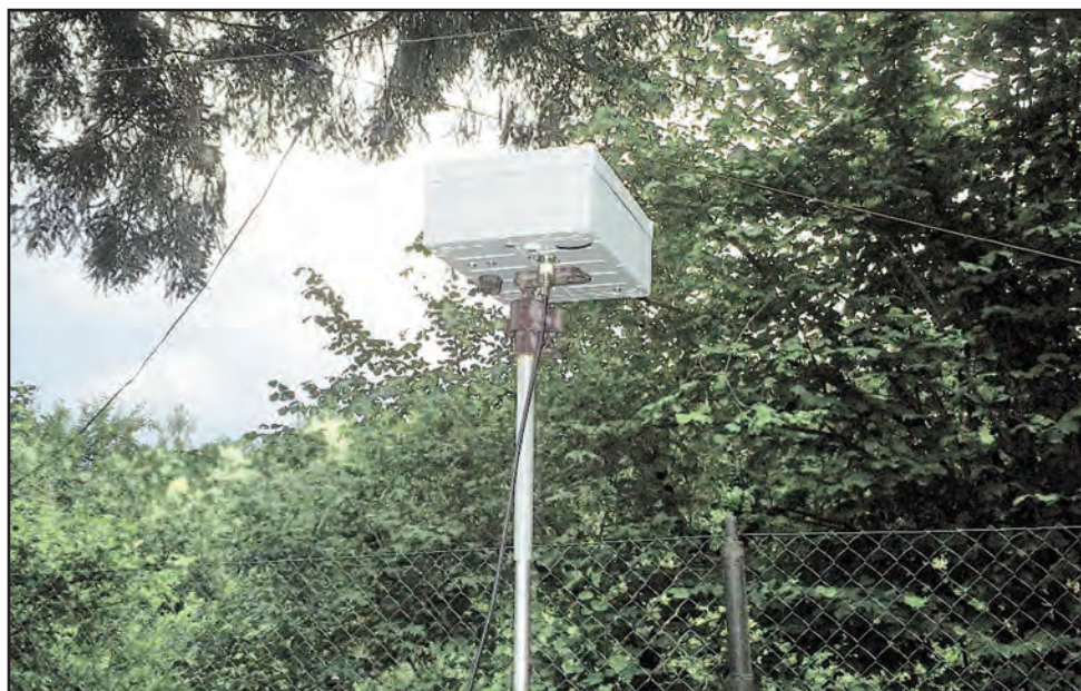
Obr. 5: Umístění feritové antény
