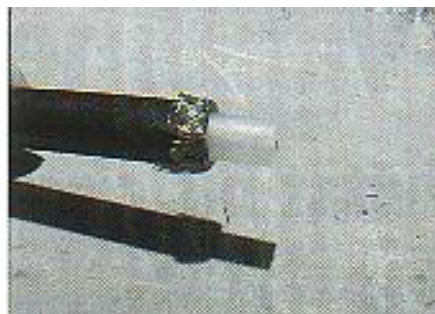
Fot. 6.4.2. Zakończenie kabla stanowiącego kondensator
