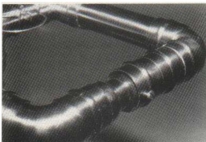
Fot. 9.2.3. Widok od strony pojemności
